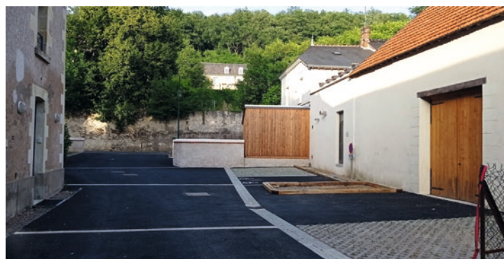
L'impasse des Étangs nouvellement aménagée
